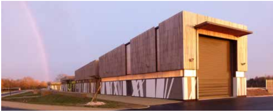
Bardage monolame (section 90 mm x 21 mm), posé verticalement à claire voie.
